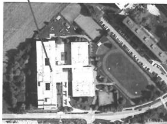
LETECKÝ POHLED NA VÝŠKOV A BUDOVU ŠKOLY
